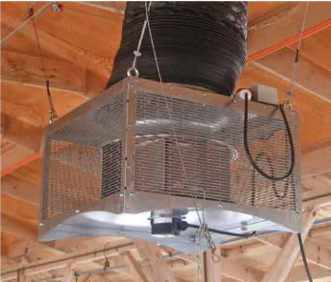
El desestratificador CUBO® modelo S/R está alojado en una caja de acero recubierto de cinc con un ventilador de aluminio para servicio severo. Incluye una rejilla protectora sobre la entrada de aire y un ducto de toma de aire superior que se engancha al mismo.
