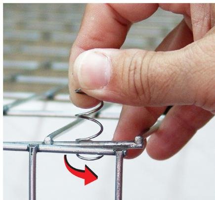
B) Gire el resorte en sentido contrario a las agujas del reloj hasta que el extremo del resorte encaje sobre la varilla del panel lateral.
