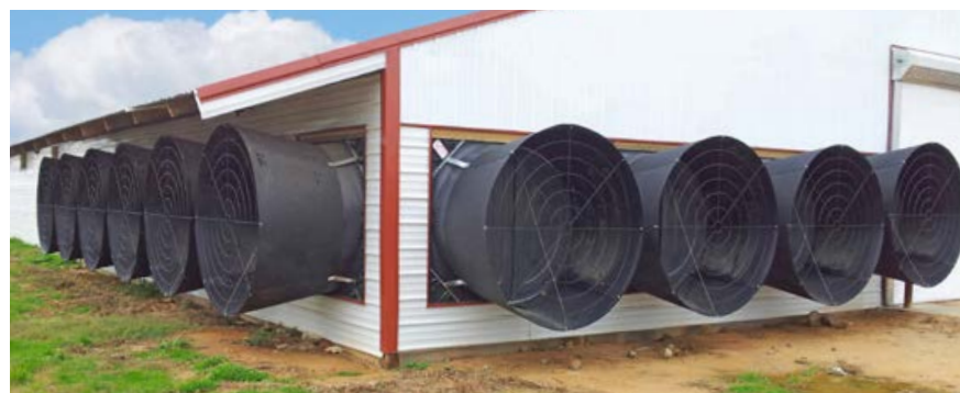
Ventilateurs ENDURA® de 145 cm (57 pouces) Chore-Time, écoénergétiques et résistants à la corrosion
