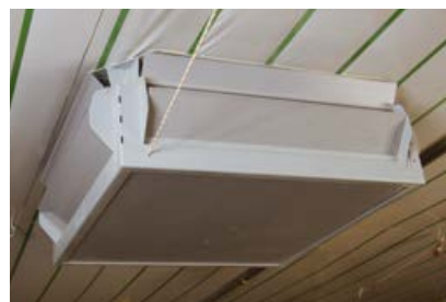
Entrées d'air de combles
