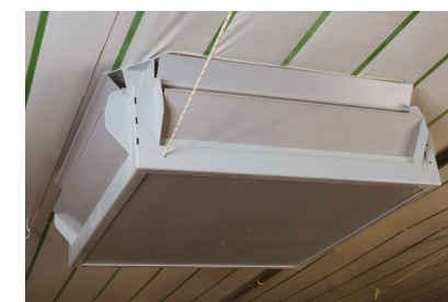
Entradas de aire en el ático
