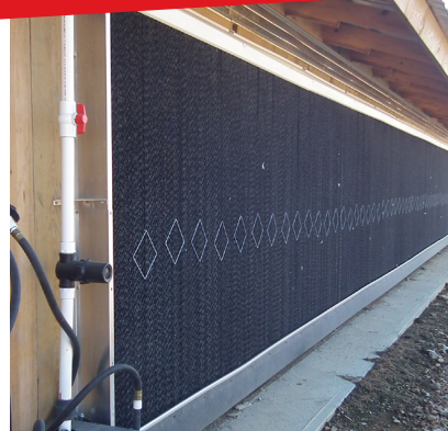
Enfriamiento evaporativo TURBO-COOL™
